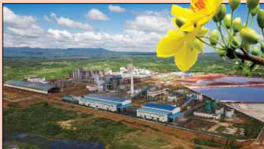
▲ Toàn cảnh Nhà máy sản xuất alumina - Công ty TNHH MTV Nhôm Lâm Đồng - TKV (LDA)
